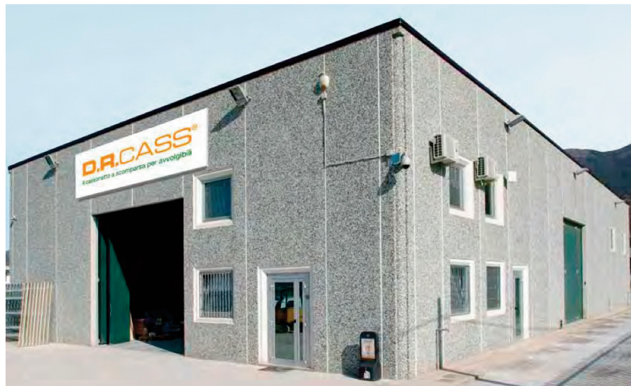
Un capannone dello stabilimento di Atena Lucana
